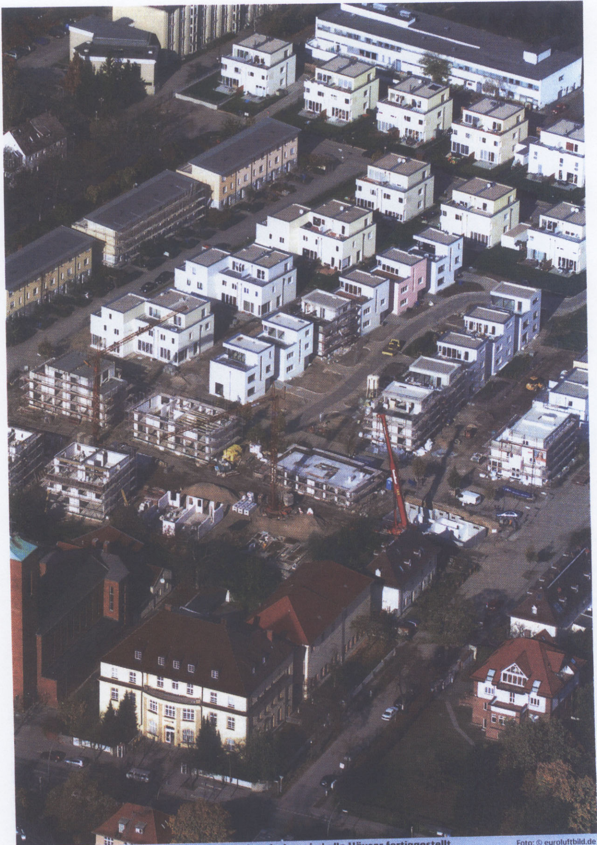
Kranarbeiten im letzten Bauabschnitt der cds. Inzwischen sind alle Häuser fertiggestellt.
